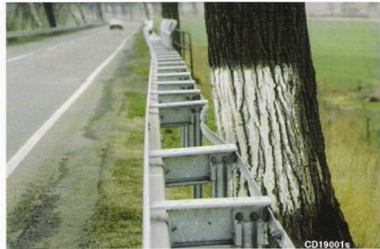
Bild 4: Beispiel für Schutzplanken bei Bäumen mit geringem Abstand zum Fahrbahnrand
